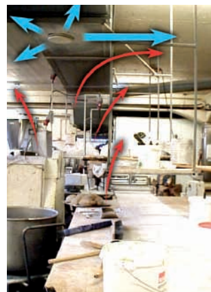
Olycklig placering av tilluftsdon över bakbord
